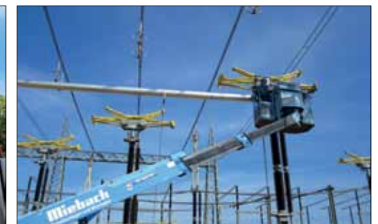
Verwaltungsgebäude der Miebach Schaltanlagen GmbH in Dortmund und Montage einer 420 kV-Anlage
